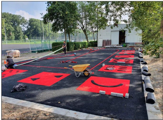
techniek veldjes bij aanleg
