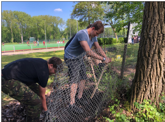
weghalen hekwerk langs bomentalud
